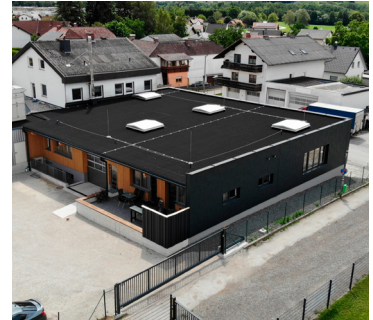
Der neue Anbau wurde in Holzriegelbauweise errichtet.
